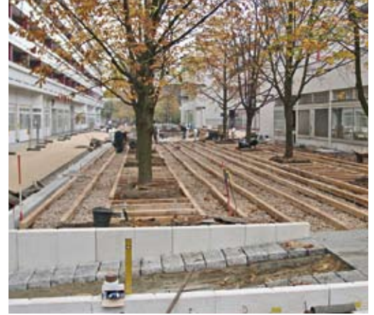
Befreiung: Nach dem Abbruch entstand unter den Kastanien ein luftiges Holzdeck
